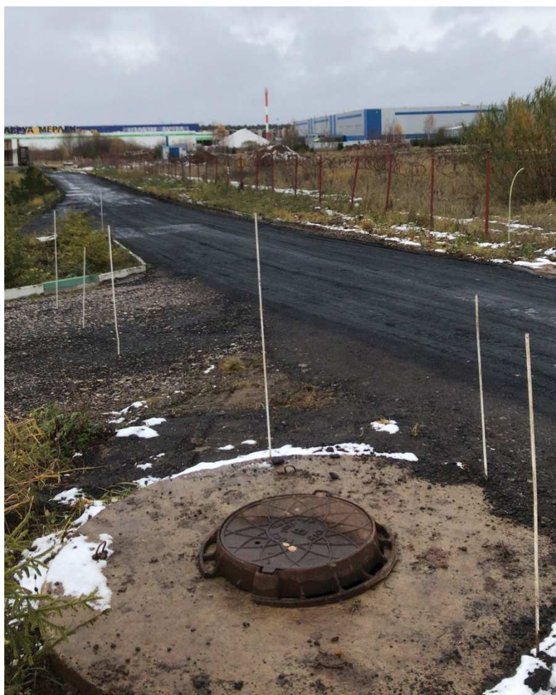
Рисунок 4 – Фотофиксация существующего состояния территории.
